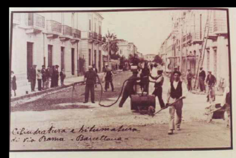
Via Roma. Cilindratura e bitumatura
