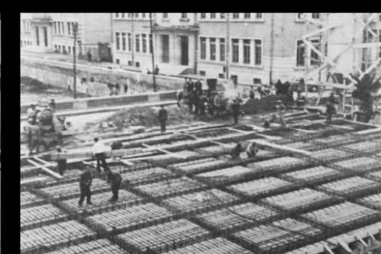
Copertura Torrente Longano
