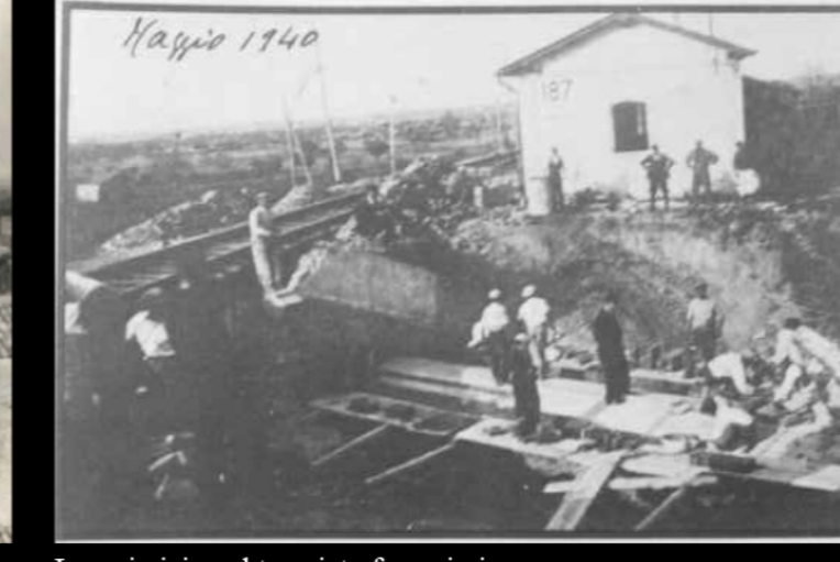
Lavori vicino al tracciato ferroviario
